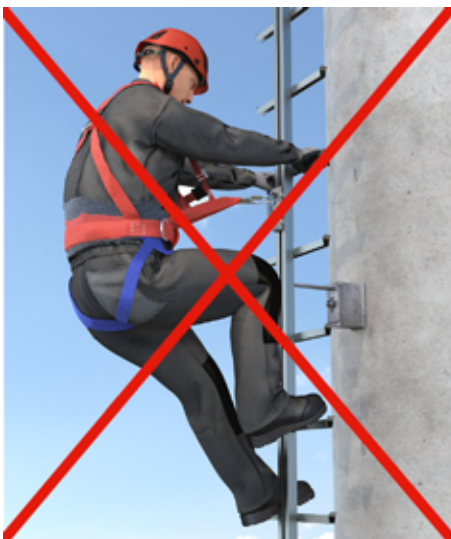
Abb. 78 Unzulässige Verlängerung des Abstandes Körper zum Auffanggerät durch zu locker angelegten Gurt
