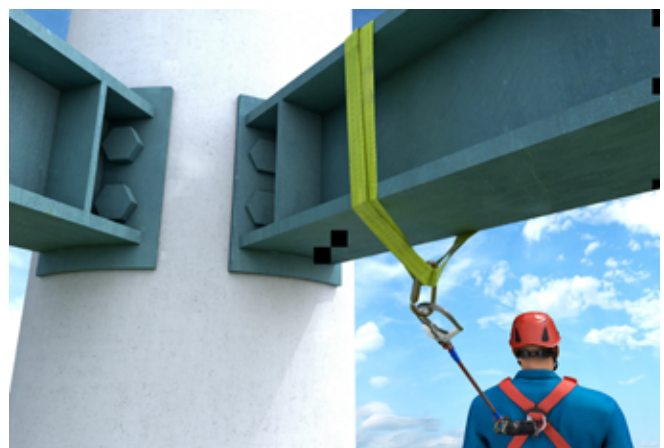
Abb. 58 Beispiel einer temporär genutzten Anschlagmöglichkeit (Stahlträger)
